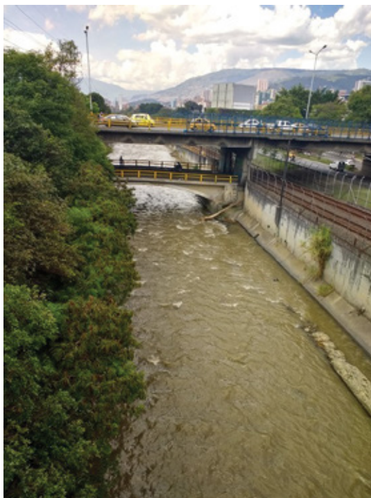
Figura 22 El río luego de pasar por la estación de La Aguacatala. Se observa el antiguo puente de la calle 12 S y encima el puente nuevo.
