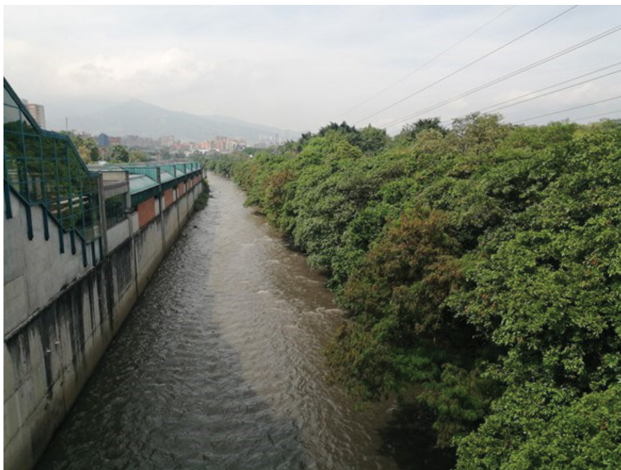
Figura 21 El río por la zona de Aguacatala. A su lado la estación del metro
